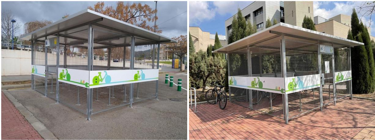
**Figura 42:** Aparcamientos cerrados para bicicletas que han entrado en funcionamiento en 2021. Disponen de alimentación eléctrica para la carga de baterías de vehículos de movilidad personal.
