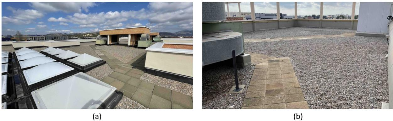
**Figura 41:** (a) y (b) Reparación y mejora del aislamiento del techo de la Escuela Superior de Tecnología y Ciencias Experimentales.
