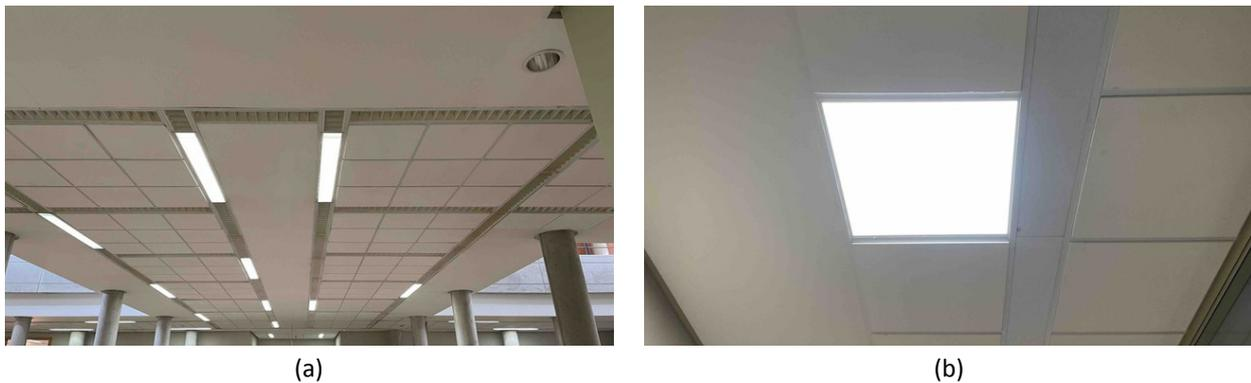
**Figura 40:** Sustitución de luminarias fluorescentes por tecnologías led. (a) Sistema de iluminación basado en tubos fluorescentes que se sustituye. (b) Nuevas placas con iluminación led.
