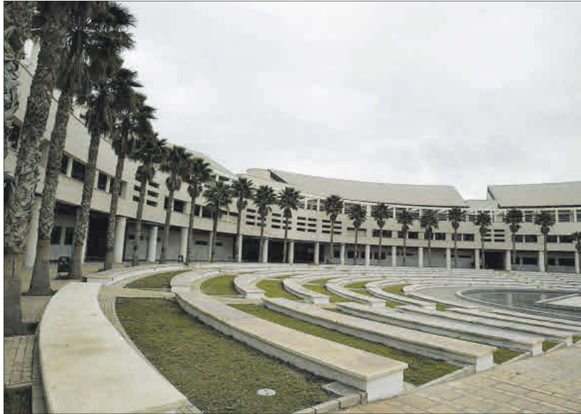
El Aulario Dos de la Universidad, en cuyos pasillos se rodaron escenas de la cinta.
