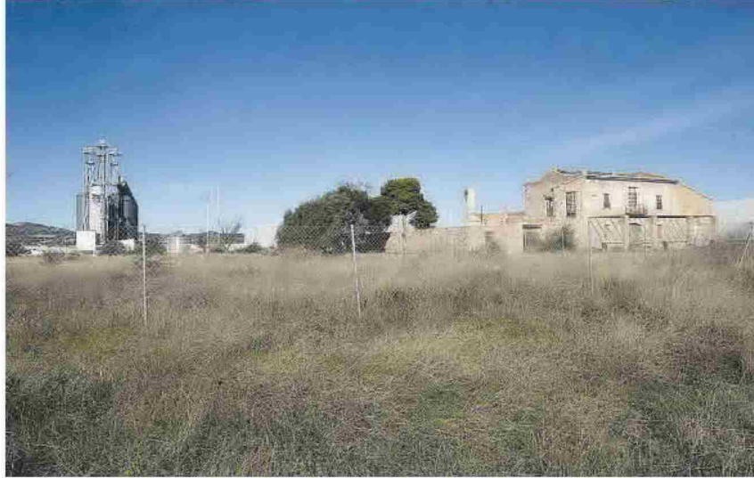
Solar de Parc Sagunt I donde se va a instalar el Campus Battery.
