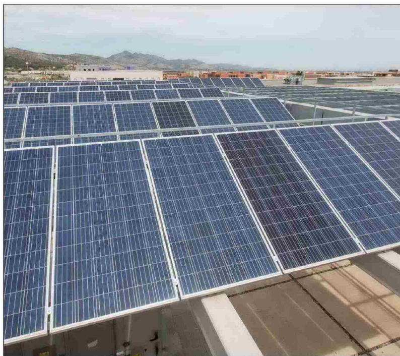
Trabajos de instalación de placas solares en uno de los edificios del campus de la UJI.
