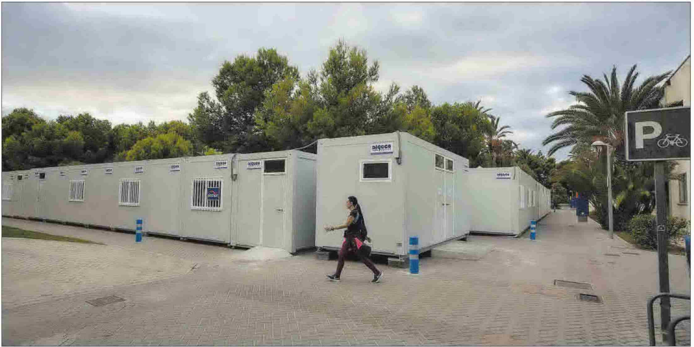
Uno de los paseos peatonales del campus está jalonado de prefabricadas tras colapsar parcialmente uno de los antiguos pabellones del Ejército.
