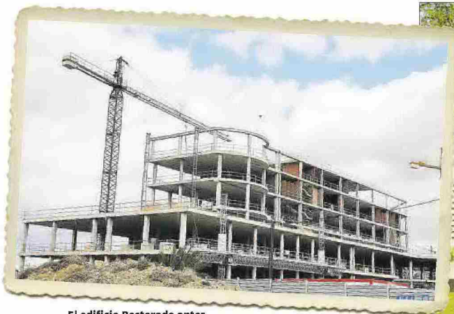
El edificio Rectorado antes y después, situado en el campus de Elche.
