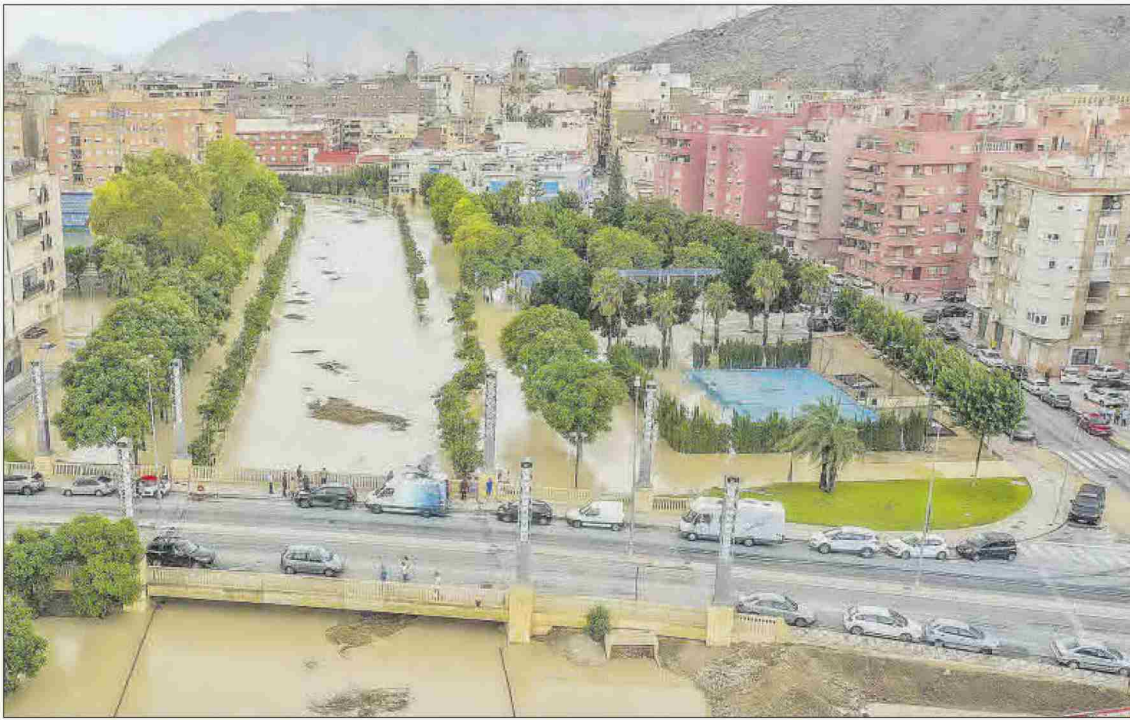
Aspecto de un barrio totalmente inundado por una DANA en la Vega Baja.
