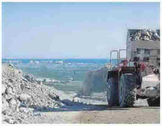
Pretenden aprovechar los restos de las obras.
