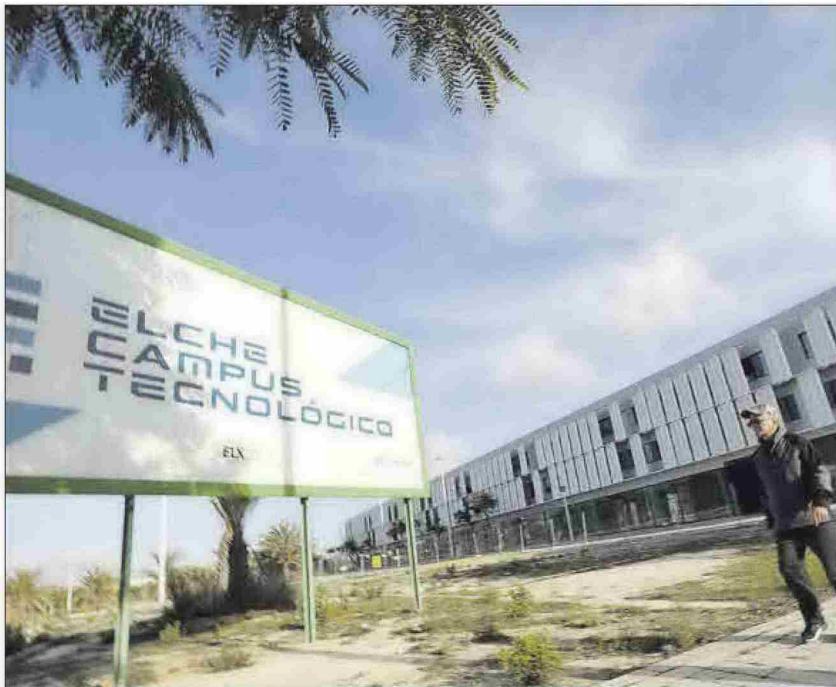
El primer edificio del Campus Tecnológico de Elche será estrenado por una empresa de cohetes.
