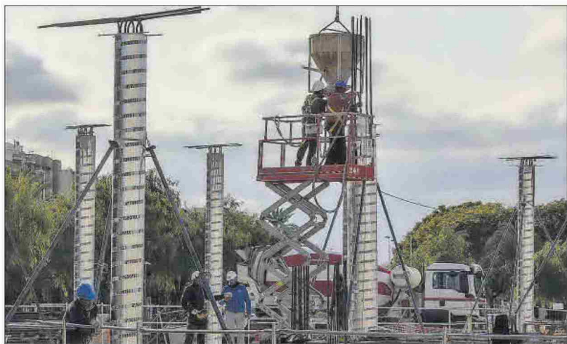
La obra comenzó a finales del pasado octubre y tiene un plazo de ejecución de 18 meses.
