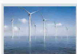
■ Arranque de una central de generación eólica marina sin el soporte de una red eléctrica externa
