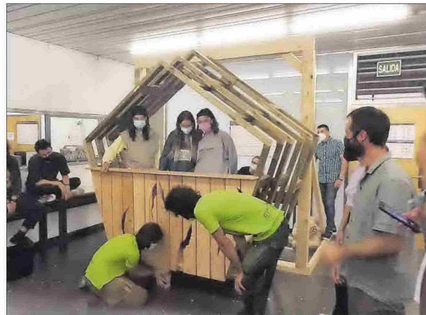
Montaje de la construcción del balcón desmontable entre el alumnado del máster.
