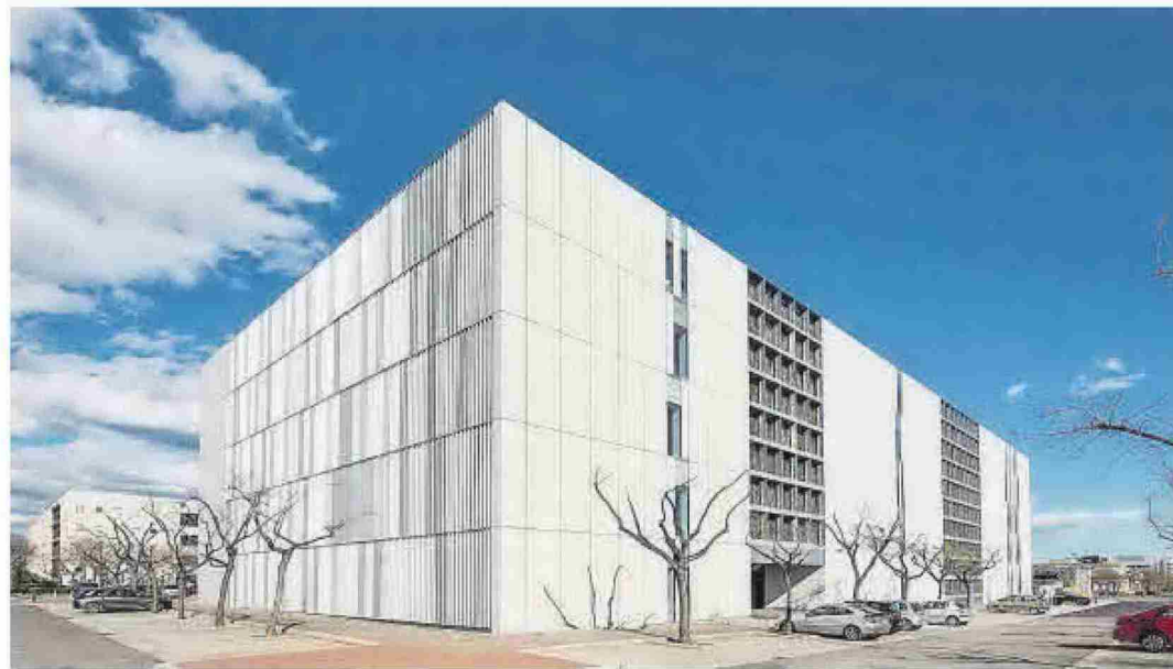
El edificio de la Facultad de Ciencias de la Salud está recubierto por Bionictile.
