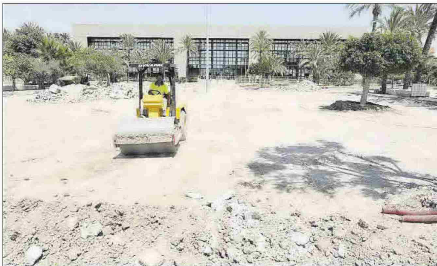
Imagen de las obras que se están ejecutando en el entorno del edificio La Galia de la UMH.
