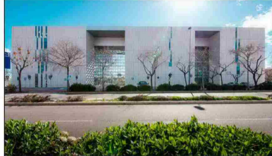
Edificio de la Facultad de Ciencias de la Salud de la UJI. EL MUNDO
