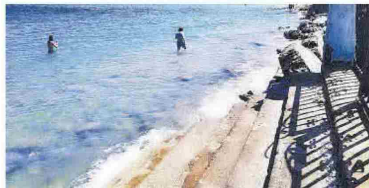
Escaleras hasta el mar tras la desaparición de la orilla. A. PADILLA
