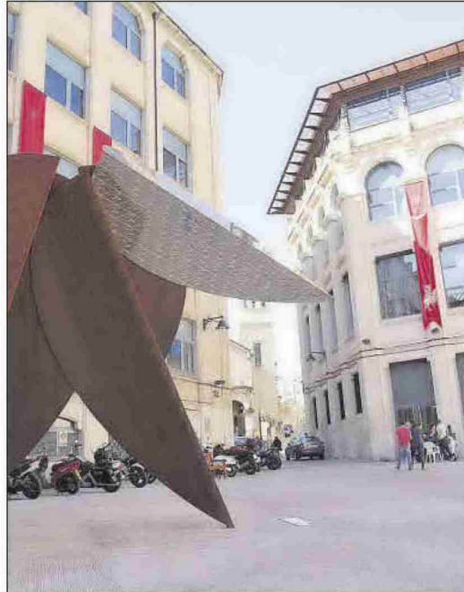
Edificios del Campus de Alcoy de la UPV.
