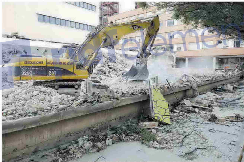
Imagen del derribo de las antiguas naves de la Escuela de Agrónomos.
