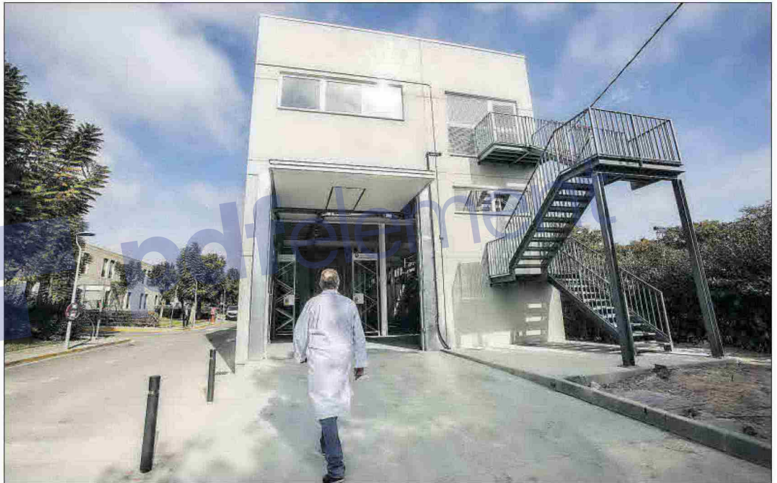
Imagen del almacén que se está levantando junto al acceso a Urgencias del Hospital de Sant Joan.
