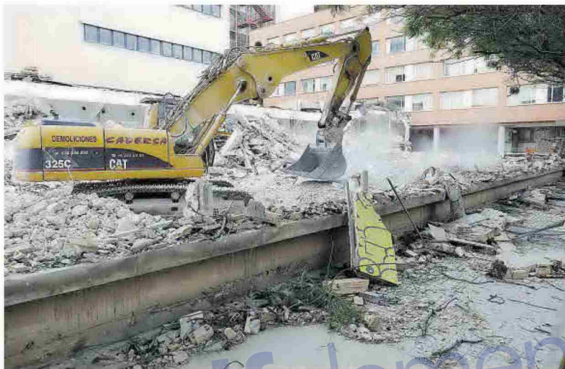
Derribos en la antigua Escuela de Agrónomos, que servirá para la ampliación del Clínico.
