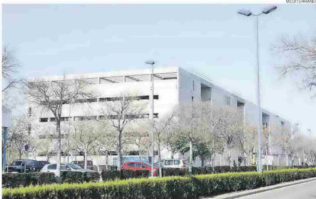
► La estructura del segundo módulo de la facultad de Ciencias de la Salud de la UJI, en marzo de este año.
