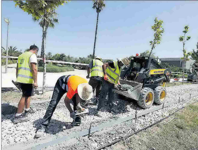
Obras de construcción del circuito de running en el campus de Elche durante esta semana. ANTONIO AMORÓS
