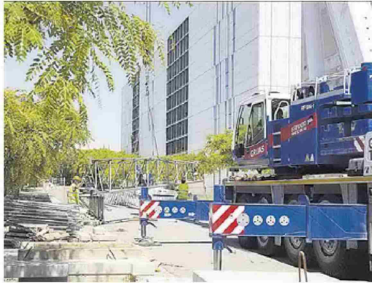
Las máquinas han comenzado a trabajar en la fachada del centro.
