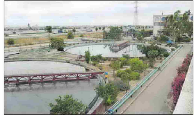
La depuradora de Pinedo ha sido uno de los espacios analizados.
