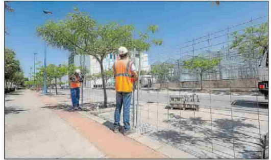
Obras del 2º módulo de la Facultad de Ciencias de la Salud. LEVANTE EMV
