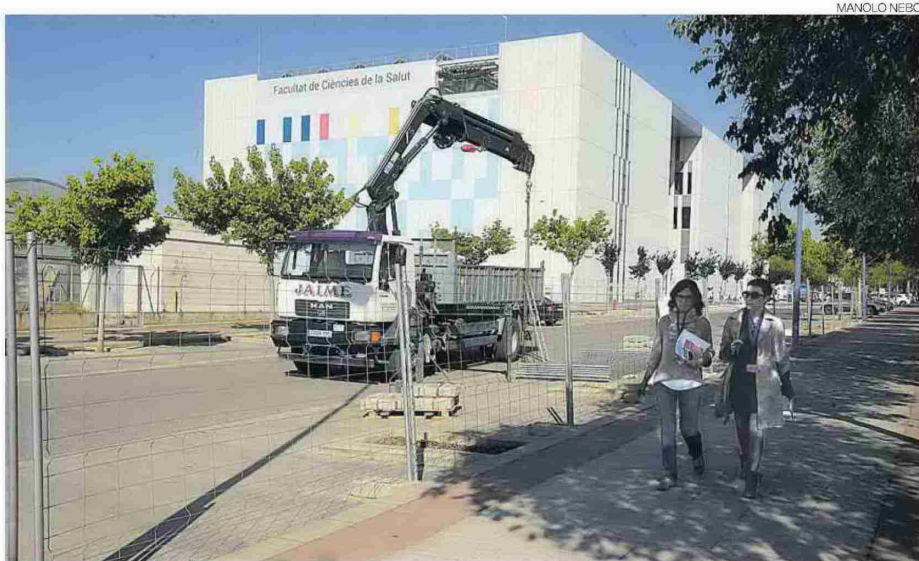
► Trabajos que está ejecutando la empresa Becsa en la UJI para construir el segundo módulo de Medicina.
