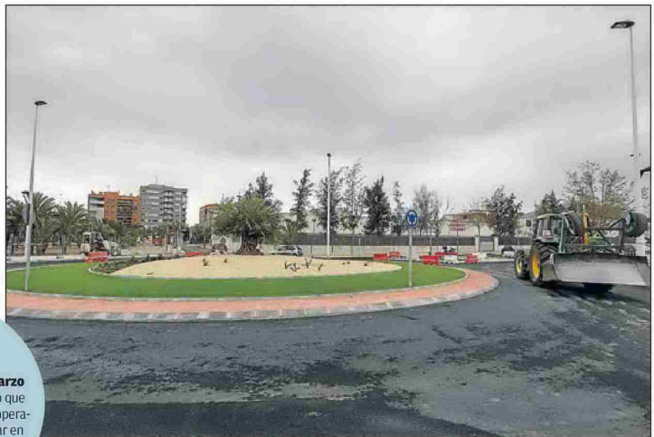
La construcción de rotondas es clave para descongestionar el tráfico en este enclave. ANTONIO AMORÓS
