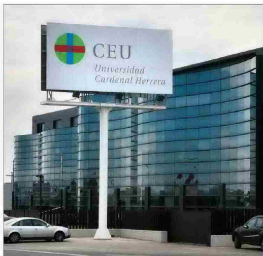
Instalaciones de la universidad CEU Cardenal Herrera en Castellón. E. TORRES
