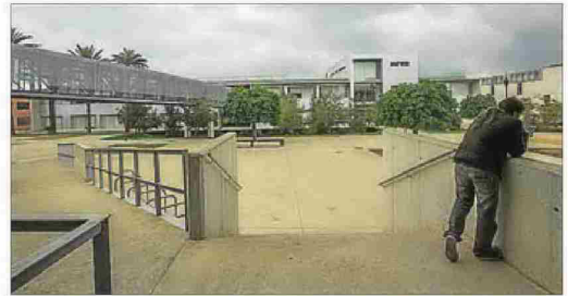
Instalaciones del Parque Científico de la UMH. ANTONIO AMORÓS
