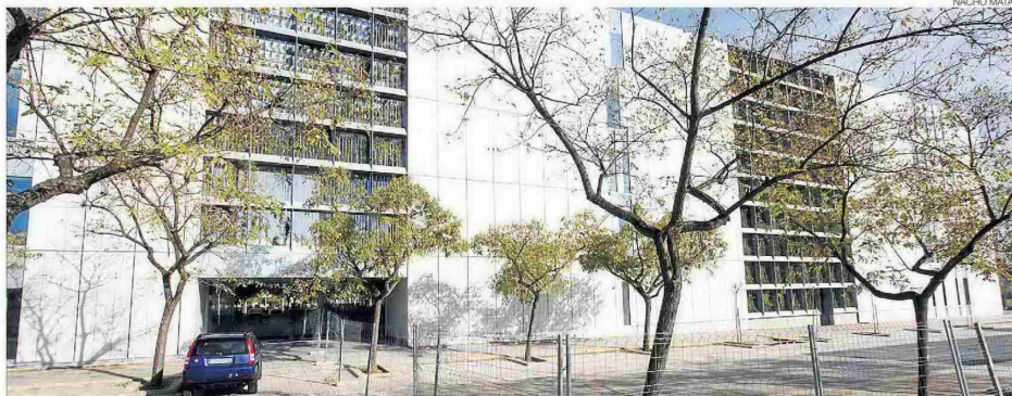
► Las obras de la primera fase de la nueva facultad de Ciencias de la Salud, con tres de los cinco módulos previstos, ya han finalizado en Riu Sec.
