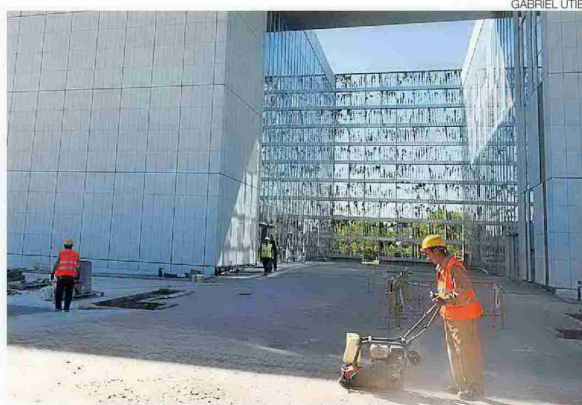
►► Tres de los cinco módulos de la facultad están ya casi terminados.
