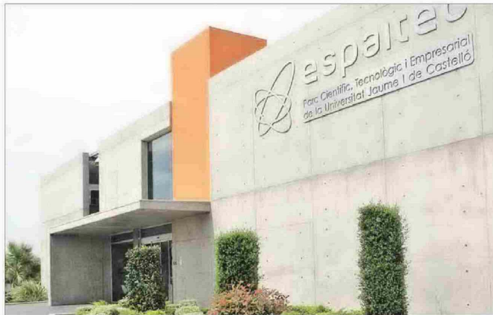
Espatec tiene ahora tres edificios en funcionamiento. LEVANTE-EMV
