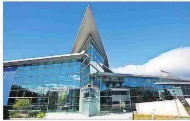
Instalaciones de un parque tecnológico en Málaga.
