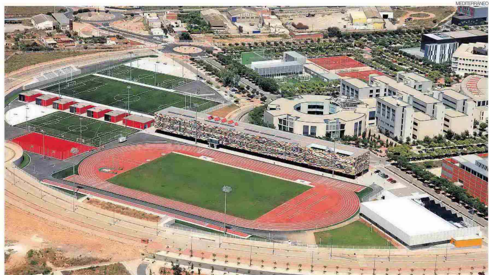
En la denominada zona exterior de las instalaciones deportivas de la UJI se desarrollarán las exhibiciones de hasta 10 modalidades.
