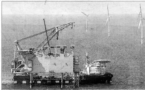
Generadores eólicos en aguas del norte de Europa. LEVANTE-EMV
