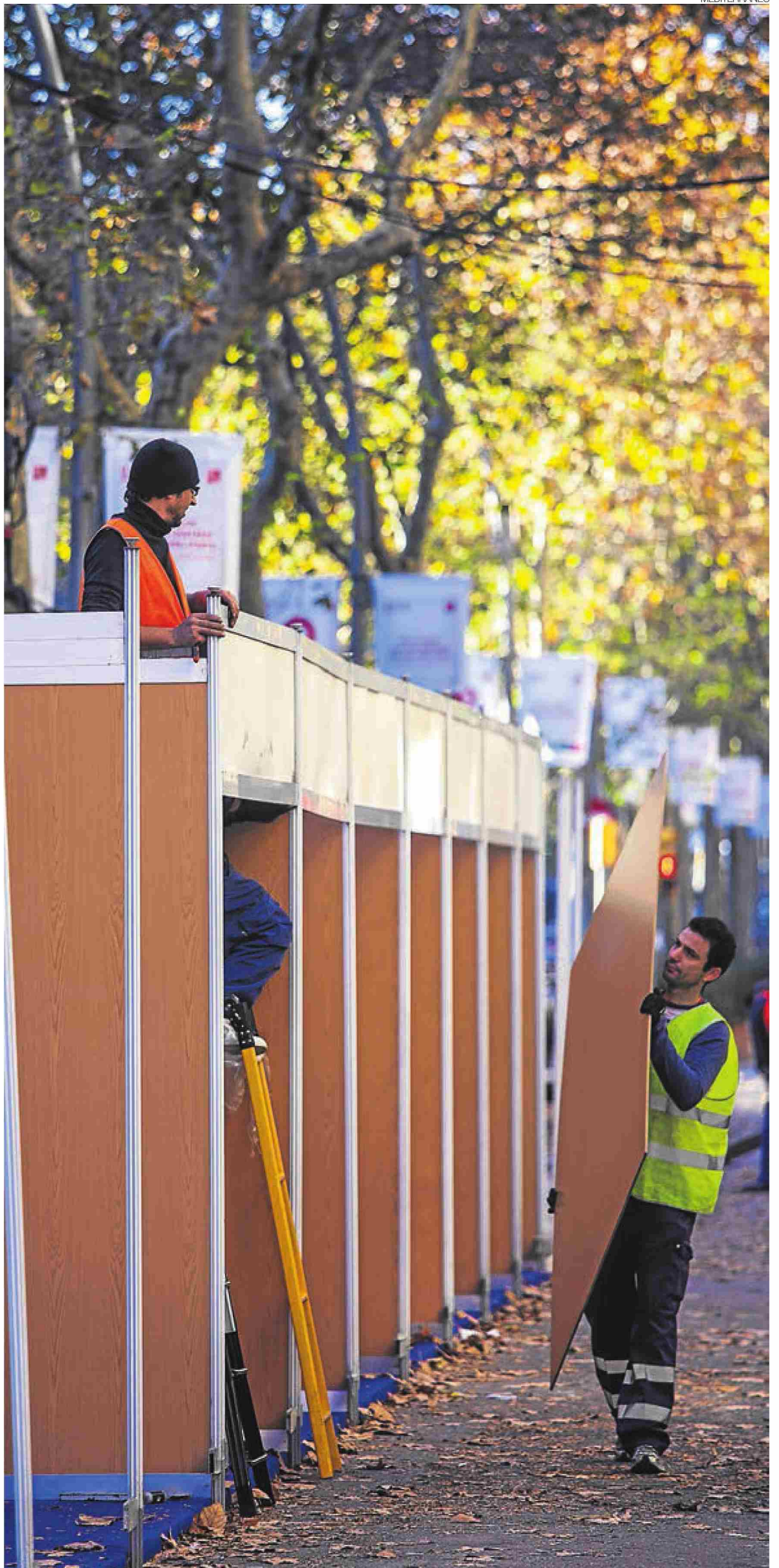
► Operarios municipales trabajan en el montaje de unas casetas. Los ayuntamientos 'tiran' del empleo.
