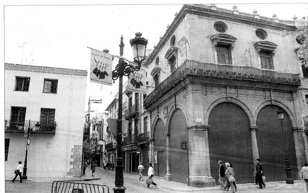
Aspecto que presentaba la Llotja antes de la restauración emprendida por la UJI. /PAU BELLIDO
