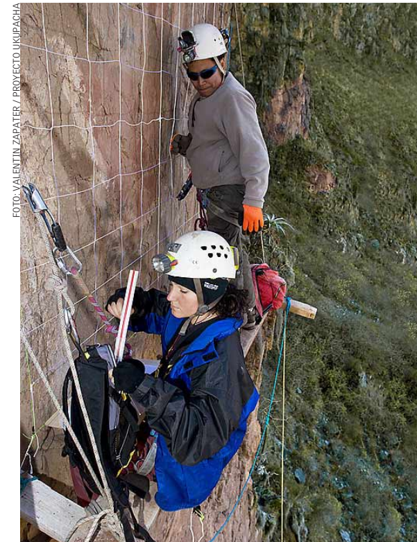
Cuerdas permiten realizar trabajos cómodamente.
