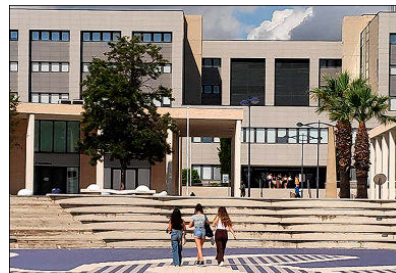
Instalaciones de la UJI.
