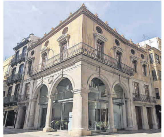
Imagen actual de la fachada de la lonja, sede de la UJI en el casco urbano.
