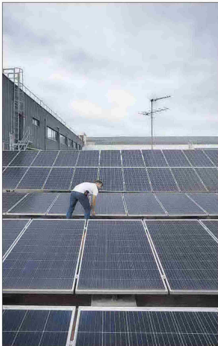
Instalación de paneles solares.
