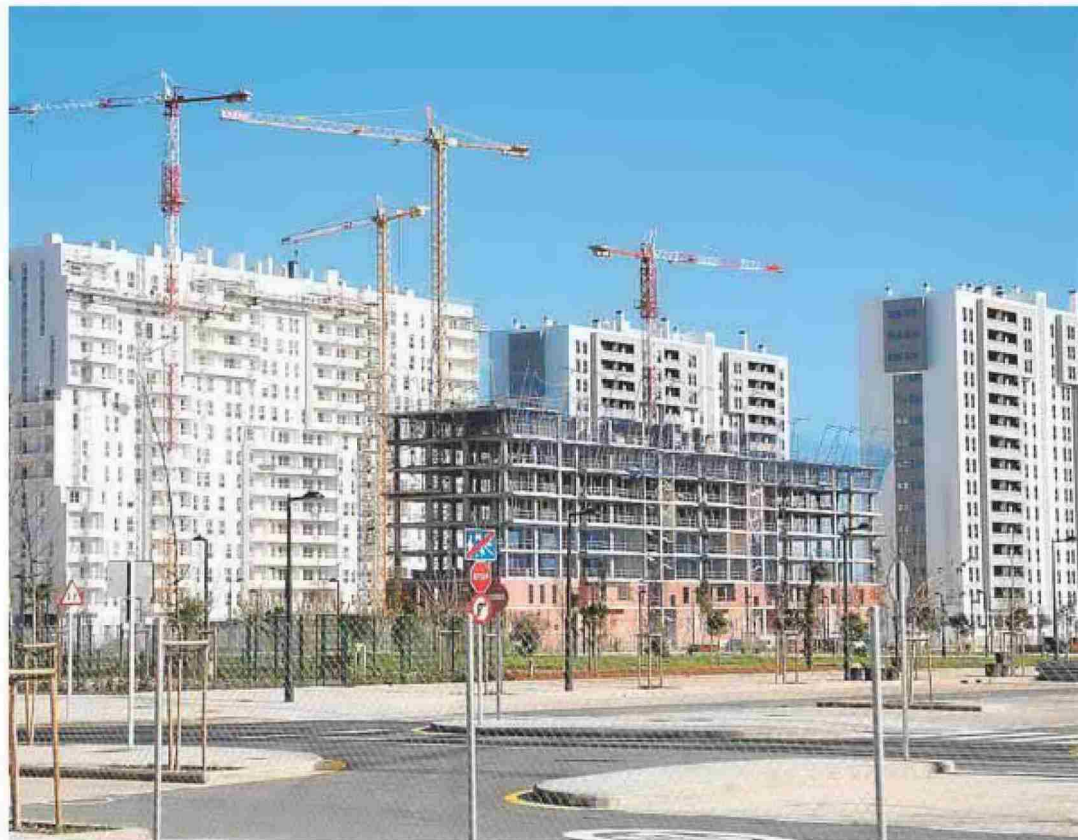
Viviendas en construcción. EFE/MIGUEL ÁNGEL POLO
