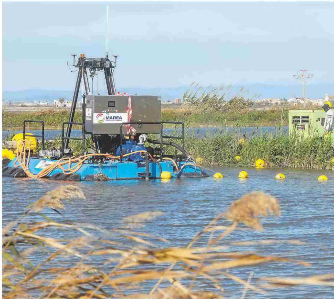
Una excavadora retira lodos en uno de los canales de la Albufera. IRENE MARSILLA
