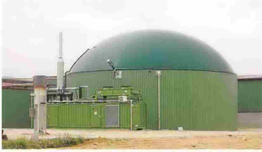
Digestor de una granja que convierte el estiércol en humus y metano. LP
