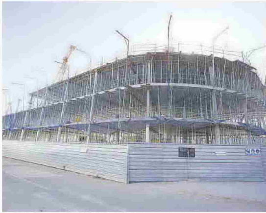
Residencia en construcción en Racó dels Pins, Burjassot. FRANCISCO CALABUIG
