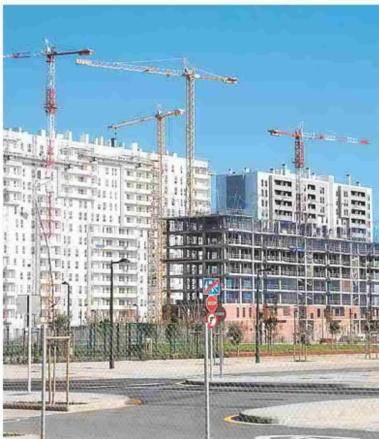
Viviendas en construcción. EFE/MIGUEL ÁNGEL POLO
