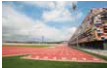
INSTAL·LACIONS ESPORTIVES A L'AIRE LLIURE
